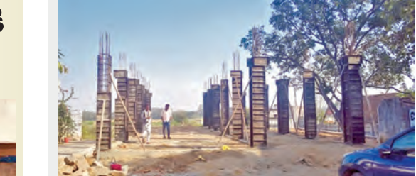
అంతర్రిగ్గాడ లో పిల్లల వరకు లేదన పాఠశాల నిర్మాణ పనులు.
